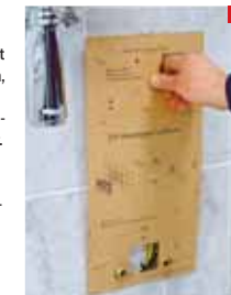
6 Links die neuen Eckventile samt Dichtringen, rechts der neue Durchlauferhitzer. Eventuell eignet sich die Aufhängung nicht und man muss sie entfernen
