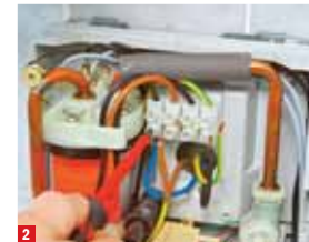
2 Sind die elektrischen Leitungen spannungsfrei, lösen Sie die Schrauben in den Lüsterklemmen und ziehen die Adern des Durchlauferhitzers heraus
