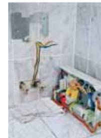
2 Sind die elektrischen Leitungen spannungsfrei, lösen Sie die Schrauben in den Lüsterklemmen und ziehen die Adern des Durchlauferhitzers heraus
