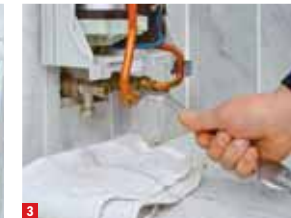
3 Vorm Lösen der Wasserleitungen drehen Sie den Haupthahn zu. Da sich meist noch stehendes Wasser in der Leitung befindet und herausfließt, ...
