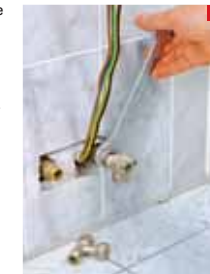
3 Vorm Lösen der Wasserleitungen drehen Sie den Haupthahn zu. Da sich meist noch stehendes Wasser in der Leitung befindet und herausfließt, ...
